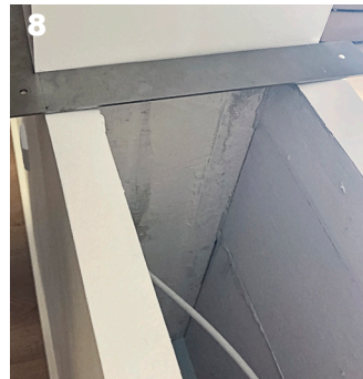
8 De 2 vægge skal være i vatter / The 2 wall must be in level.
